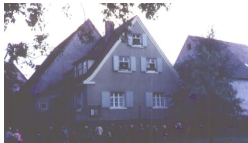
Gemeinschaftshaus und Kindergarten im "Gässla"
